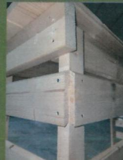
Als letzten Schritt müssen die Nut- und Federbretter (1940x146x22,5 mm) als Dach auf den Seitenteilen angebracht werden. Dazu fügen Sie die Bretter ineinander und legen diese passend auf dem Dach auf. Die Bretter müssen nun von hinten bündig mit dem Seitenteil verbunden werden. Dazu verschrauben Sie die Dacheindeckung vorne, hinten und in der Mitte mit je einer Schraube (4x45 mm).
