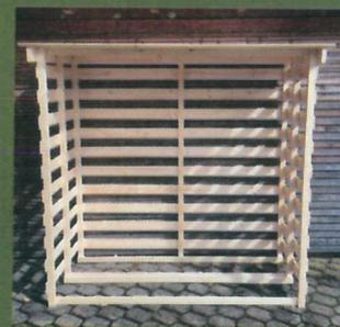
Nun werden die Rautenbretter (1790x96x12,5 mm) in der gleichen Höhe und Position der seitlichen Rautenbretter befestigt. Die Bretter sollten dazu wieder vorgebohrt werden und an den Seitenteilen mit 2 Schrauben und in der Mitte mit einer Schraube (3,5x30 mm) verschraubt werden.
